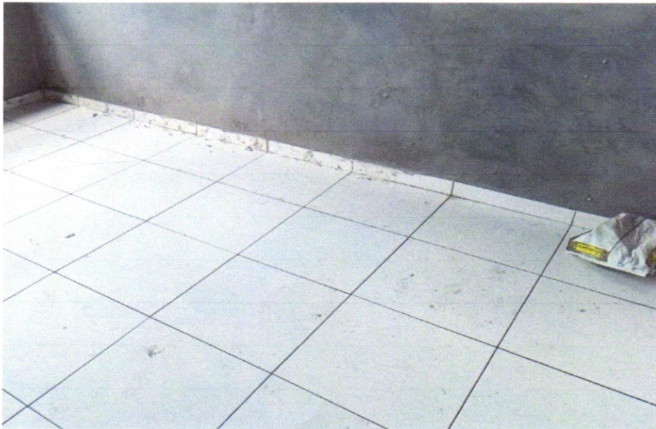
Foto 03 – RODAPÉ CERÂMICO DE 7CM DE ALTURA COM PLACAS TIPO ESMALTADA EXTRA DE DIMENSÕES 45X45CM. AF_06/2014
