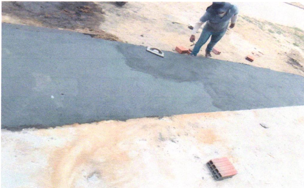
Foto 06 – PISO EM CONCRETO 20 MPA PREPARO MECÂNICO, ESPESSURA 7CM. AF_09/2020
