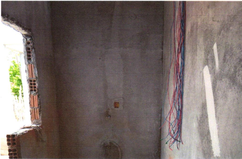
Foto 07 – CABO DE COBRE FLEXÍVEL ISOLADO, 4 MM 2 , ANTI-CHAMA 0,6/1,0 KV, PARA CIRCUITOS TERMINAIS - FORNECIMENTO E INSTALAÇÃO. AF_12/2015
