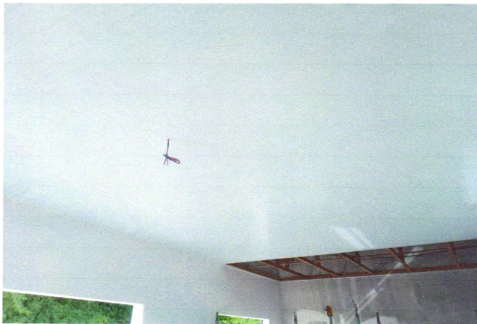
Foto 13 – Forro de pvc, em réguas de 10 ou 20 cm, aplicado, inclusive estrutura para fixação (perfis em PVC) marca Araforros ou similar, instalado - Rev 06_10/2021
