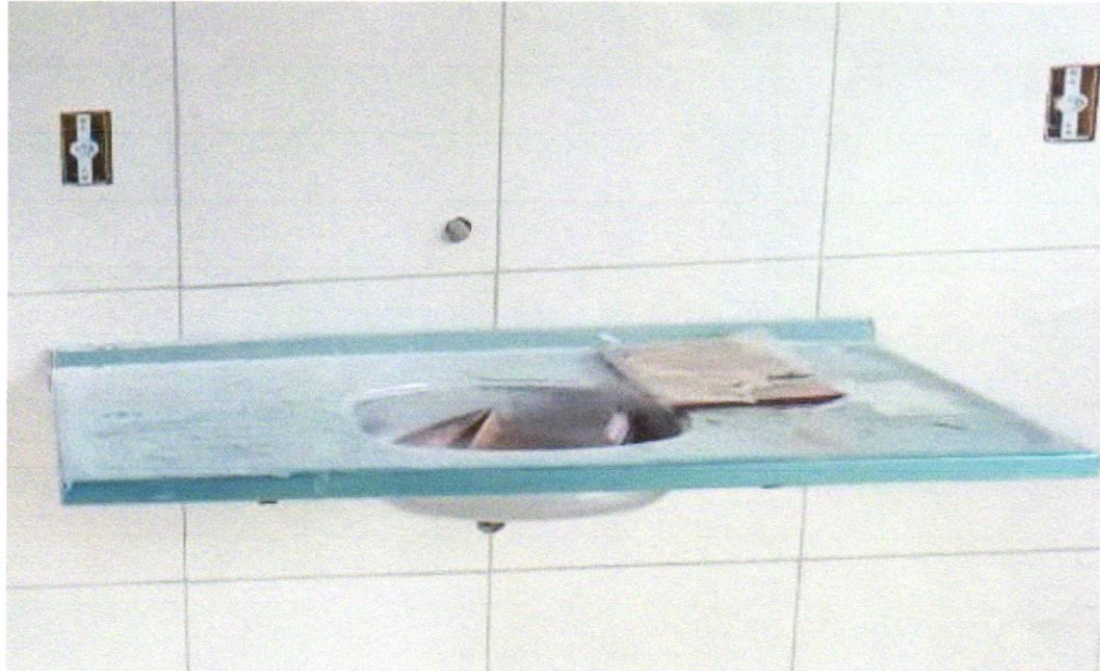
Foto 15 – Pia de cozinha com bancada em aço inox, dim 1,20x0,60m c/ 01 cuba, válvula cromada, sifão cromado e torneira cromada, concretada e assentada. Rev.04
