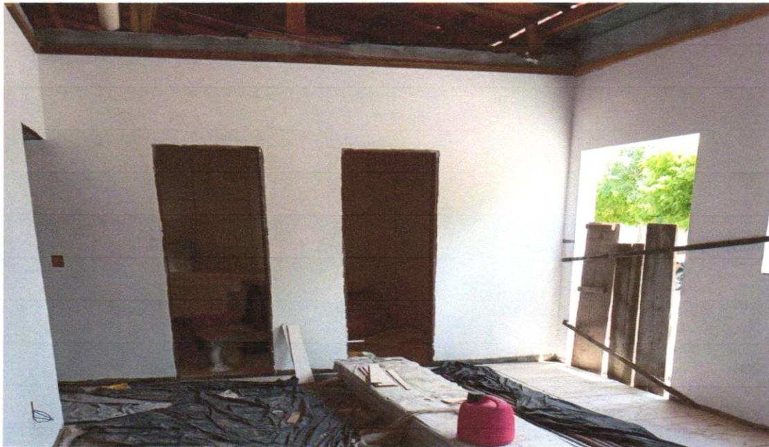
Foto 09 – APLICAÇÃO E LIXAMENTO DE MASSA LÁTEX EM PAREDES, UMA DEMÃO. AF_06/2014
