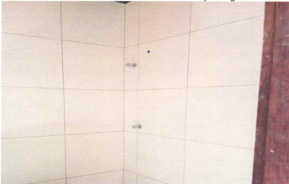
Foto 08 – REVESTIMENTO CERÂMICO PARA PAREDES INTERNAS COM PLACAS TIPO ESMALTADA EXTRA DE IMENSÕES 33X45 CM APLICADAS EM AMBIENTES DE ÁREA MAIOR QUE 5 M 2 A MEIA ALTURA DAS PAREDES. AF_06/2014
